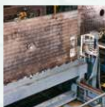
3.6 Tavole di cambio stampo, installate tra due presse p. 46-47
