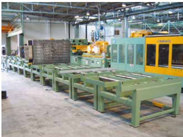
Magazzino stampi in combinazione con il carro di cambio stampi su rotaia. Una stazione di magazzino è attrezzata con multi connessioni automatiche utilizzate come stazione di pre-riscaldamento.
